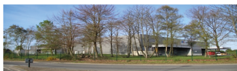
TALENDI - Rue du Boisillon à Trégueux (22)
