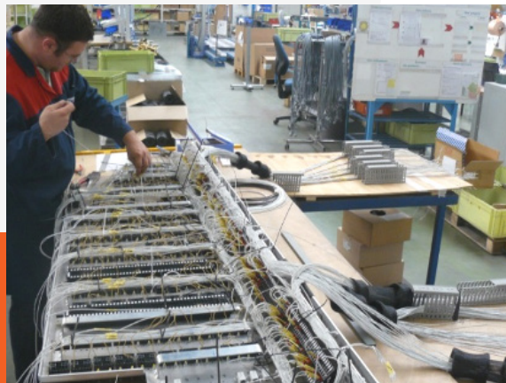
Platine électrique MI79. Assemblage de 1700 fils
