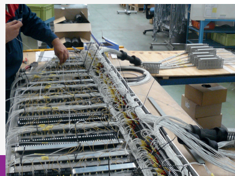
Reprise de câblage platines Électriques
